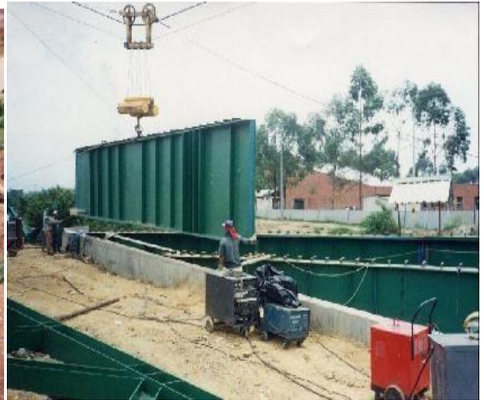
CONALVIAS S.A. Todas las obras y trabajos necesarios para el diseño, fabricación, transporte y montaje de estructura metálica para un Puente Peatonal Metálico, para la Obra Avenida Ciudad de Cali, con una sola luz de 53,00 mts
