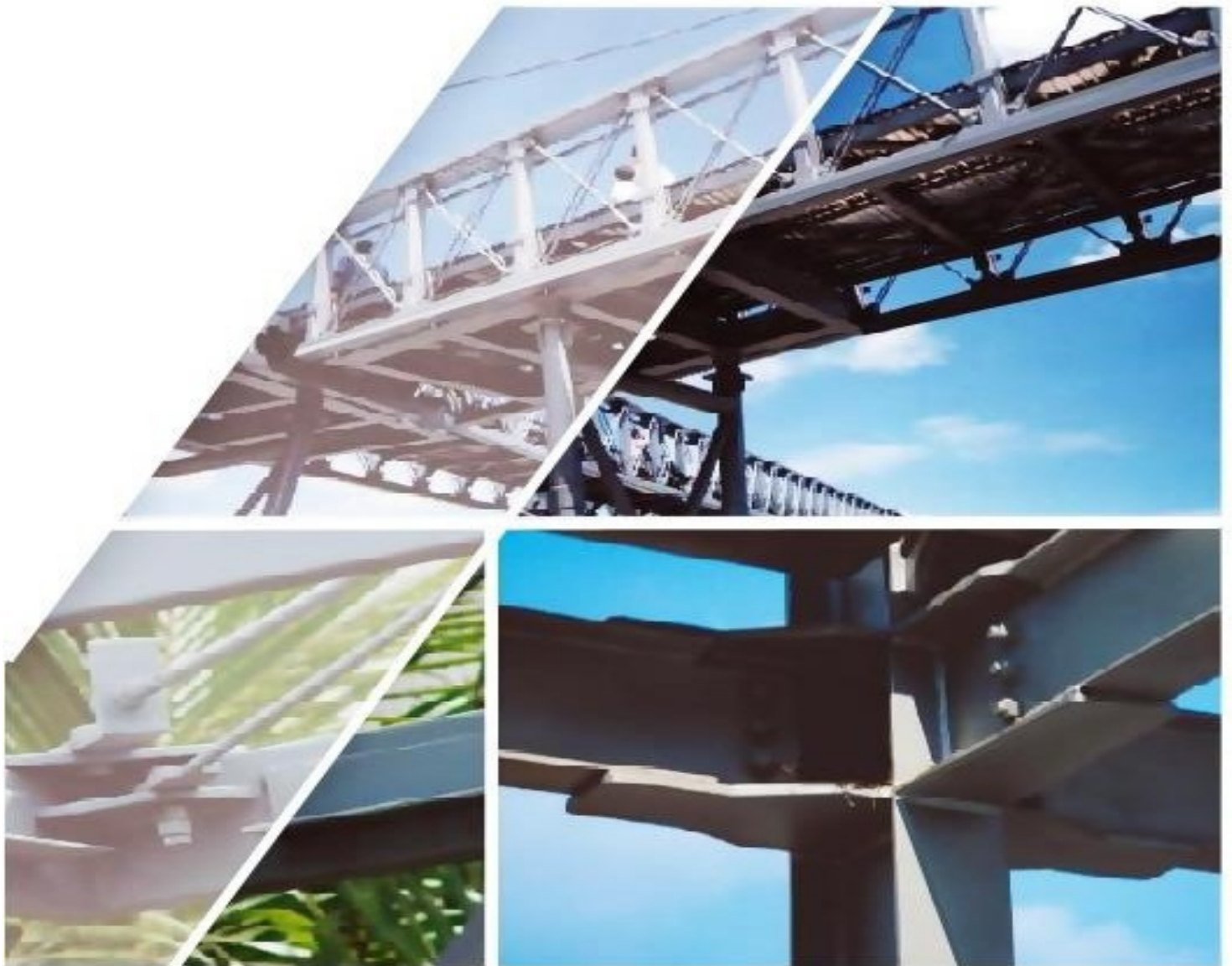
Conexión edificio Automarcas
